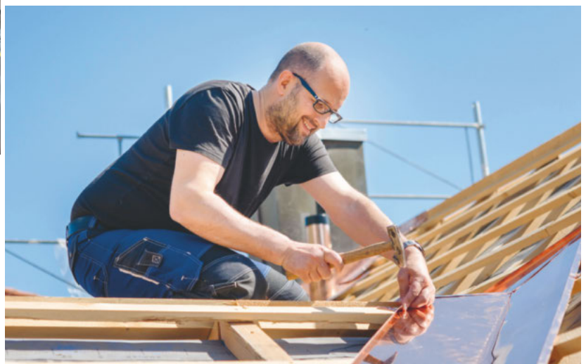
Bei Spenglerarbeiten zeigte sich der suissetec Direktor schwindelfrei.
