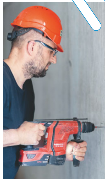
Im Rohbau konnte Christoph Schaer direkt Hand anlegen.
